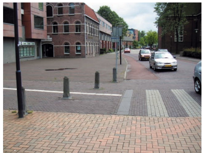
Fußgängerüberweg und Radfahrstreifen
