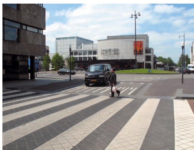
Fußgängerüberweg mit Noppenplatten
