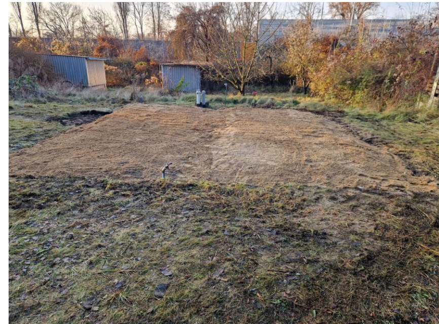
Rückbau Gartenlaube 2, Blick Richtung Westen (02.12.2025, HOWOGE)
